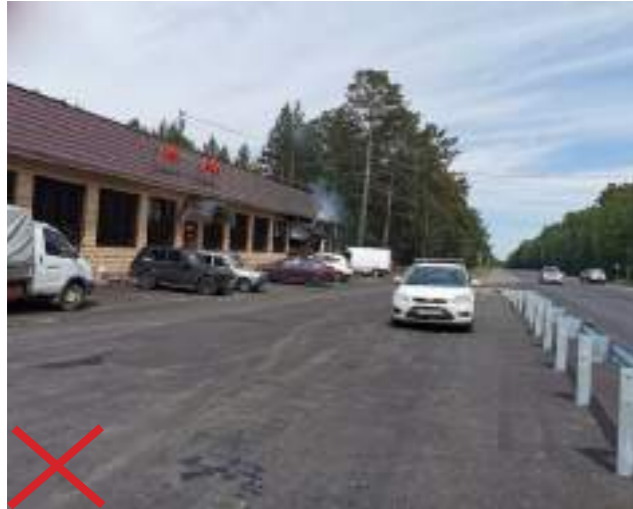
Необходимо пешеходную зону отделять от проезжей части и парковки. Недопустимо использовать парковку возле ОДС без дорожной разметки.
