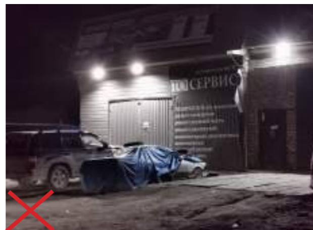
Недопустимо устанавливать светильники (прожекторы) со слепящим эффектом.
